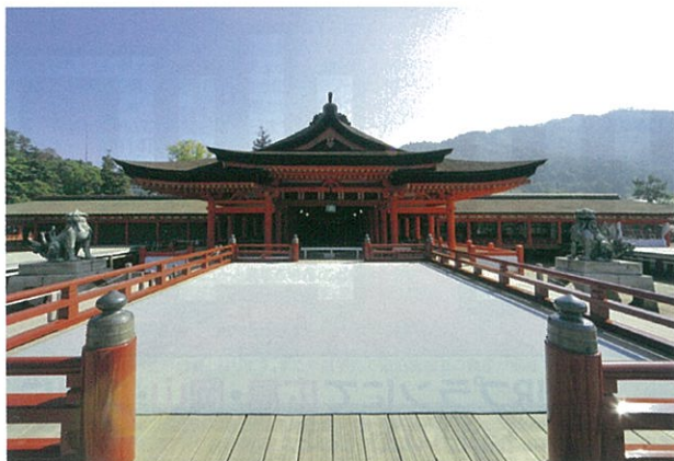
広島県 厳島神社 社殿 写真提供:広島県
