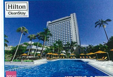
外観・屋外プール(季節営業)
